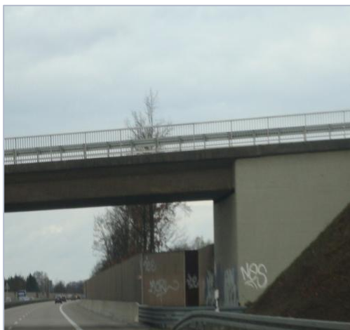
Рис. 1.15. Совмещенный с искусственным сооружением начальный участок железобетонного шумозащитного экрана
