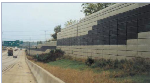
Рис. 1.16 - Шумозащитные экраны из кирпича разных цветов (а), комбинация шумопоглощающих конструкций из дерева (б) и шумопоглощающих разноцветных панелей (в)
