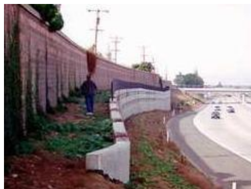
Рисунок 8.42 - Комбинированное шумозащитное сооружения «грунтовый вал – экран– подпорная стенка» со стороны источника шума.
