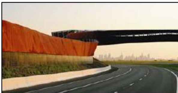
Рис 1.8. Волнообразный верх экран зрительно уменьшает его высоту.
