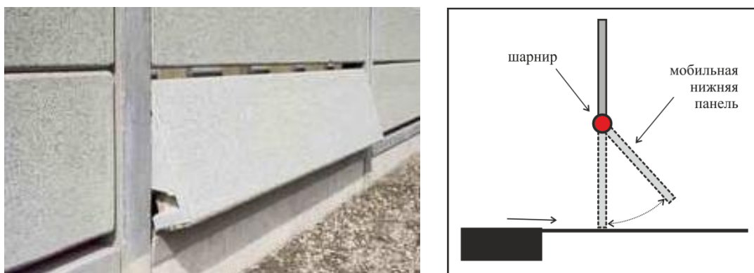
Рисунок 8.31 - Подвешенная нижняя панель экрана для отвода воды с проезжей части.
