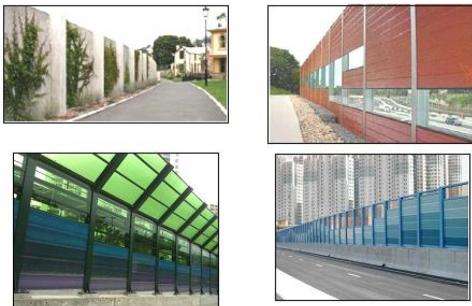
Рис 1.10 - Повышение эстетических качеств экранов за счет применения ребристой конструкции и включения прозрачных элементов
