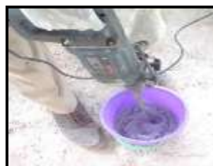
8.26-rasm. Epoksidli smolani tayyorlash tartibi
