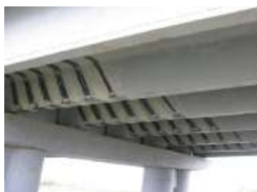
Qiya va normal kesimlar bo‘yicha bosh to‘sinlarni kuchaytirish
