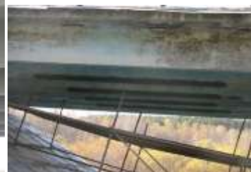
Qiya va normal kesimlar bo‘yicha bosh to‘sinlarni kuchaytirish
