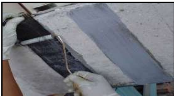
8.28-rasm. Tolaning yo'riqnomasiga muvofiq qirrali rolikni qo'llash
