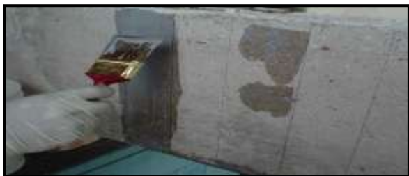
8.27-rasm. Belgilangan joyga epoksidli smolani suvash
