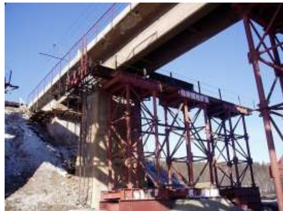
6.22-rasm. Oraliq qurilmani ko‘ndalang surish uchun MIK S va g‘ildiratish yo‘llari elementlaridan vaqtinchalik pirsni qurish
