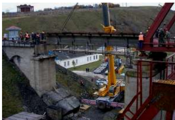
6.19-rasm. Temir yo'l ko'prigining temirbeton oraliq qurilmasini bitta avtoyo'l krani bilan almashtirish
