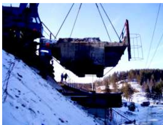
6.11-rasm. Eski demontaj qilinadigan oraliq qurilmani gabarit tashqarisidagi vaqtinchalik tayanchga o‘rnatish
