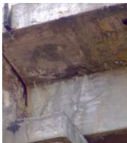
5.37-rasm. Oraliq qurilmaning tayanch uchastkasida qiya yoriqlarning hosil bo‘lishi
