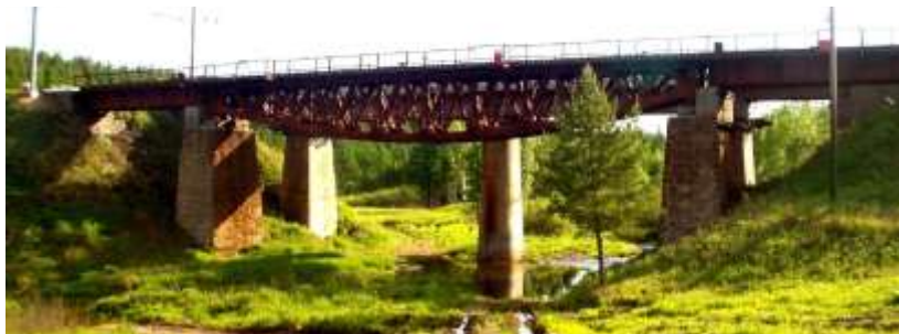
Rasm 2.16. Harakati yuqorisida shaparak fermali metall to‘sin-uzlukli oraliq qurilma
