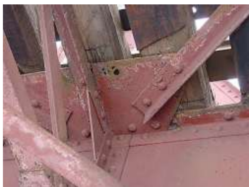
5.25-rasm. Butun devorli oraliq qurilma bosh to‘sinini kashak (biriktiruvchi qism) larining korrozion shikastlanishlari
