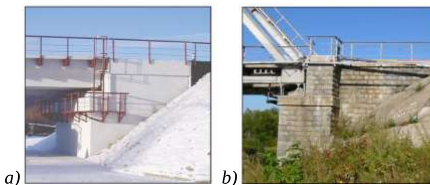
Rasm 2.21. Ekspluatatsiya qilinayotgan yirik monolit qirg‘oq tayanchlari: a – betonlilar; b – toshli qoplamasi bilan butobetonlilar
