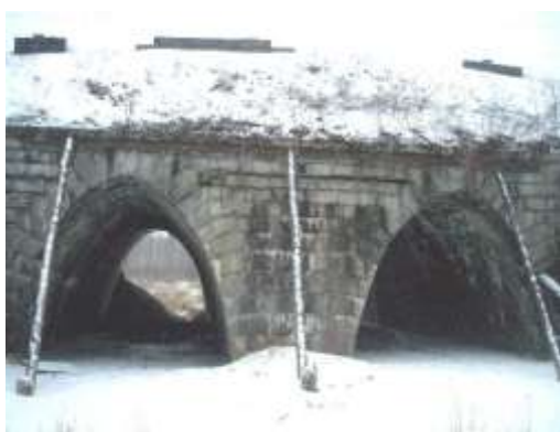
Rasm 2.3. Ovalsimon kesimli ikki ko‘zli tosh quvur konstruksiyasi
