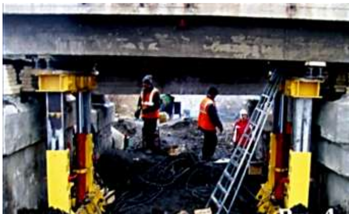
6.30-rasm. SAYDU (CFVIIC) ishlab chiqqan temir yo‘l ko‘priklari oraliq qurilmalarini ko‘tarish uchun texnologik majmua
