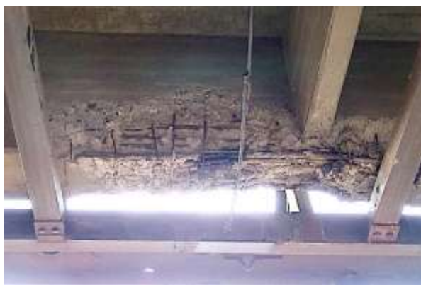
5.39-rasm. Oraliq qurilma to'sini armaturasining yalang'ochlanishi bilan beton singan bo'laklari
