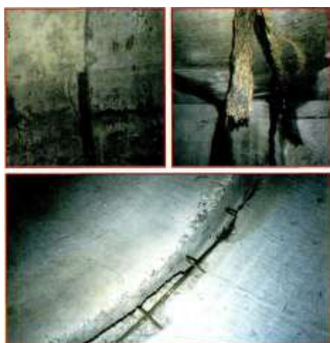
5.18-rasm . Suv o'tkazuvchi quvurlar zvenolari orasida berkitilmagan choklarning mavjudligi
