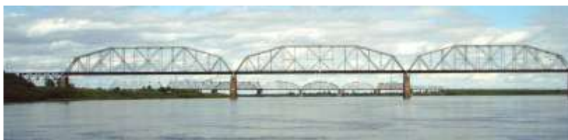
Rasm 2.15. Harakati pastda shaparak fermali po‘lat to‘sin-uzlukli oraliq qurilmalar
