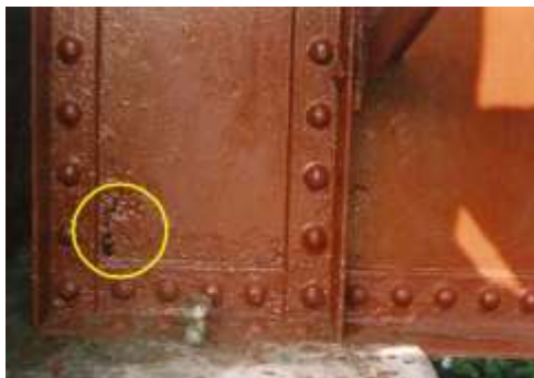
5.23-rasm. Oraliq qurilmaning yarali korroziyasi
