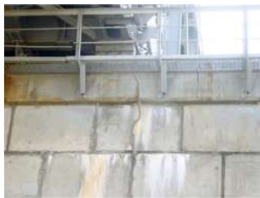
5.45-rasm. Ko‘prik tayanchi ustki qismidagi vertikal yoriqlar
