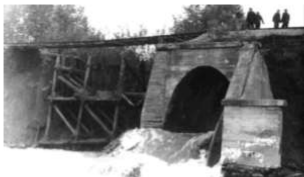
5.12-rasm. Toshqin davrida quvur zonasida ko'tarmaning yuvib ketilishi Suv o'tkazuvchi quvur kallaklarida grunt va suv oqimi o'zanlari mustahkamligi materialining yuvilib ketilishi oqibatida chuqurlik paydo bo'lishi kuzatiladi (5.13-rasm ).
