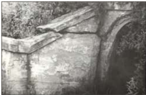
5.2-rasm. Bo'ylama yoriqning rivojlanishida kallak qanoti (yon tomoni) ning uzilishi
