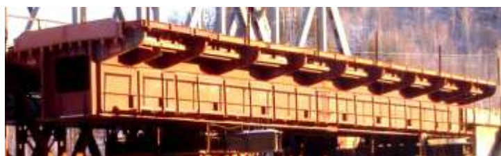
Rasm 2.14. Ballast bo'yicha harakatlanadigan ortotrop plitali qutisimon oraliq qurilmaning konstruksiyasi
