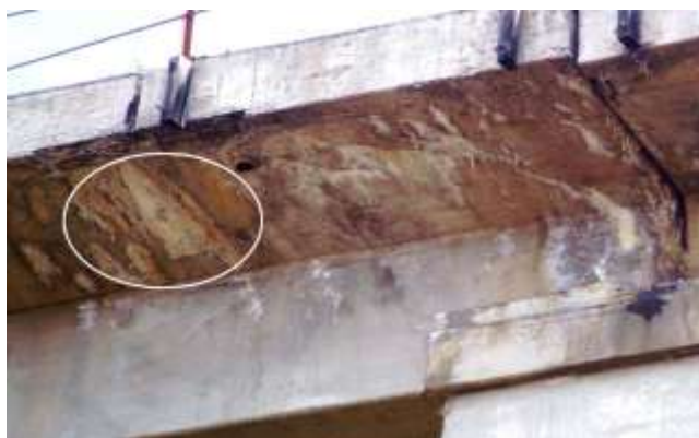
5.42-rasm. Oraliq qurilmalar armaturasi chirishining tashqi alomatlari
