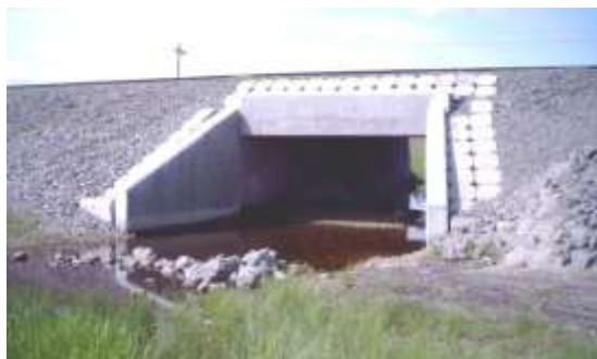
Rasm 2.5. To‘g‘ri to‘rtburchak kesimli temirbetonli quvur konstruksiyasi
