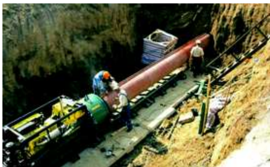
6.4-rasm. Gorizontaal burg‘ilash usuli bilan yangi quvurni qurish uchun БЛИМ BARBCO ABM 60-1 HD shnekli burg‘ilash mashinasining umumiy ko‘rinishi
