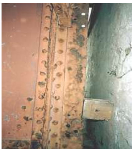
5.27-rasm. Oraliq qurilmalar bosh to'sini parchin mixli birikmalarining buzilishi
