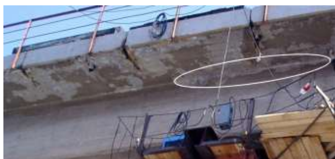
5.38-rasm. Plitaning oraliq qurilma bosh to‘siniga tutashgan zonasida gorizontal yoriqlarning hosil bo‘lishi
