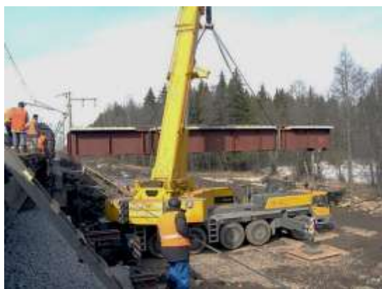
6.18-rasm. Temir yo'l ko'prigining metall oraliq qurilmasini bitta avtoyo'l krani bilan almashtirish
