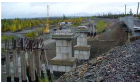
6.23-rasm. Yo‘llar soni o‘zgarishi munosabati bilan mavjud ko‘priklarning rekonstruksiya ikkinchi yo‘l uchun yangisini qurish
