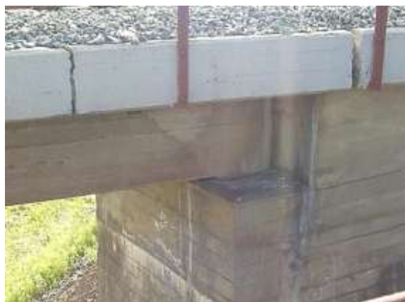
5.47-rasm. Qirg'och tayanchidagi vertikal yoriqlar
