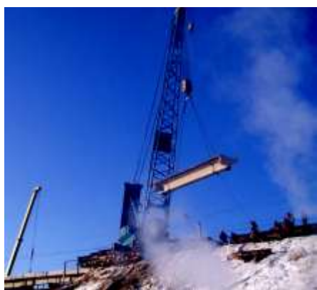
6.10-rasm. Rekonstruksiya qilinadigan ko‘prik olididagi platformaga yangi oraliq qurilmani etkazish
