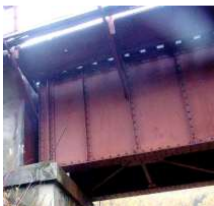
Rasm 2.11. YAxlit bosh to'sinli parchin mixlangan metall oraliq qurilmalar
