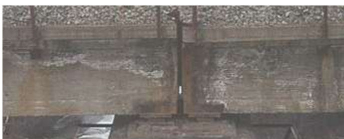
5.40-rasm. Oraliq qurilmaning bosh toʻsinlarida betonning ishqorlanishi
