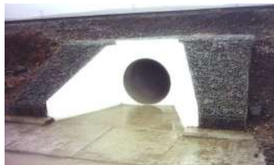
Rasm 2.6. Dumaloq kesimli temirbetonli quvur konstruksiyasi
