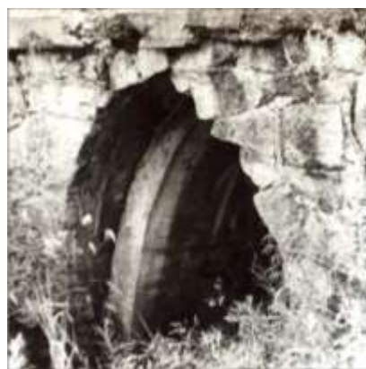
5.7-rasm. Ovalsimon kesimli quvur chetki seksiyasining cho‘kishi
