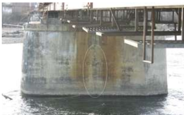
5.44-rasm. Ko‘prik tayanchi ostki qismidagi vertikal yoriqlar
