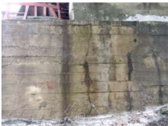
5.46-rasm. Tayanchdagi vertikal yoriqlar
