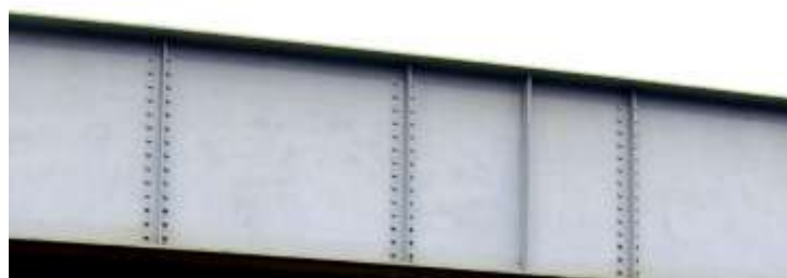
Rasm 2.12. Bolt payvandli oraliq qurilmaning konstruksiyasi
