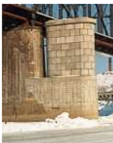
6.24-rasm. Amur daryosi (Rossiya, Xabarovsk) orqali ko'priklarning rekonstruksiyasida poydevorning eski terimidan foydalanib ikkinchi yo'l ostida tayanchni yonma-yon qurish
