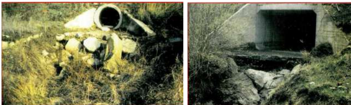
5.13-rasm . Suv o'tkazuvchi quvur kallaklarida suv oqimi o'zanining yuvilib ketilishi
