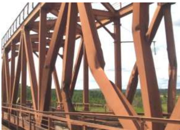
5.30-rasm. Shaparak fermali oraliq qurilma elementlarining mexanik shikastlanishlari
