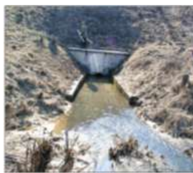
5.9-rasm. Suv oqimi normal gidravlik rejimini buzuvchi quvur o'zanining loyqa bosishi
