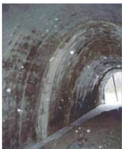
5.5-rasm. Ovalsimon kesimli toshli quvurlarda ishqorlanish jarayoni
