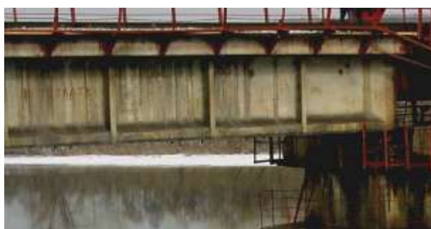
Rasm 2.19. Oldindan zo'riqtirilgan armaturali temirbeton oraliq qurilmaning fasadi
