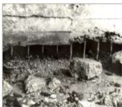
5.8-rasm. To'g'ri to'rtburchak kesimli quvur novining sinishi
