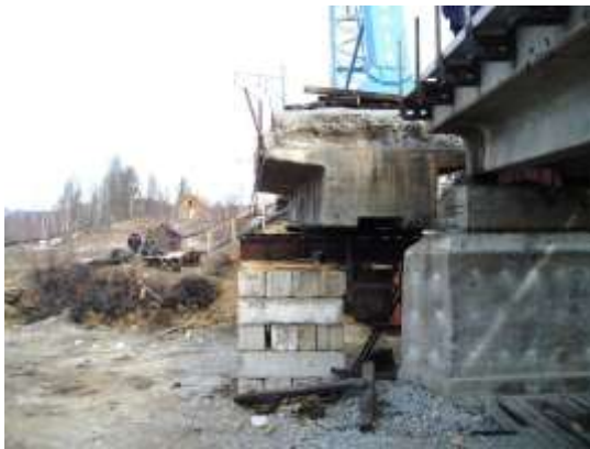
6.21-rasm. Yig‘ma betonli bloklardan yig‘ilgan vaqtinchalik tayanchlardan foydalanib temirbeton oraliq qurilmani ko‘ndalang surish
