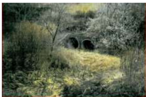
5.17-rasm . Balandligi 15 sm dan katta bo'lgan o't va daraxt-butazor o'simliklarning mavjudligi Tutashishlar germetikligining buzilishi zvenolar orasidagi choklarning buzilishiga olib keladi (5.18-rasm ).
