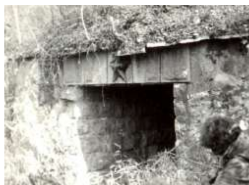
Rasm 2.4. To‘g‘ri to‘rtburchak kesimli toshli quvur konstruksiyasi
