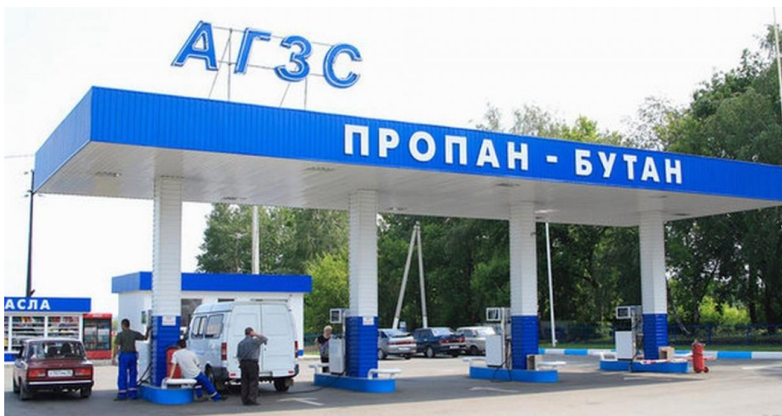
5.5-rasm. «GTC» rusumli suyultirilgan gaz quyish shoxobchasi
