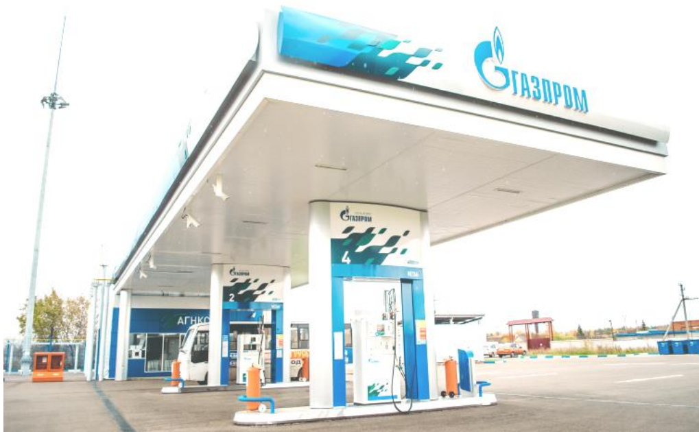
2.2-rasm. Gaz quyuvchi stansiya
