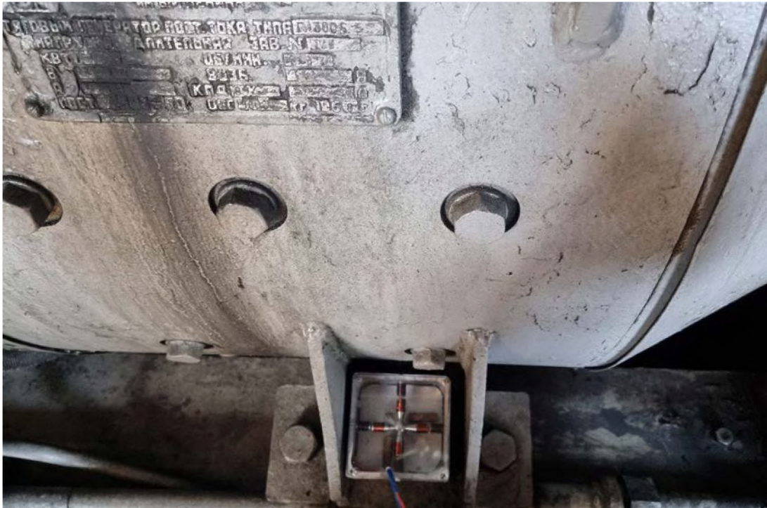
4.16- rasm. Yaratilgan IVO'-1 ni ishlab chiqarish obyektida o'rnatilgan holati
